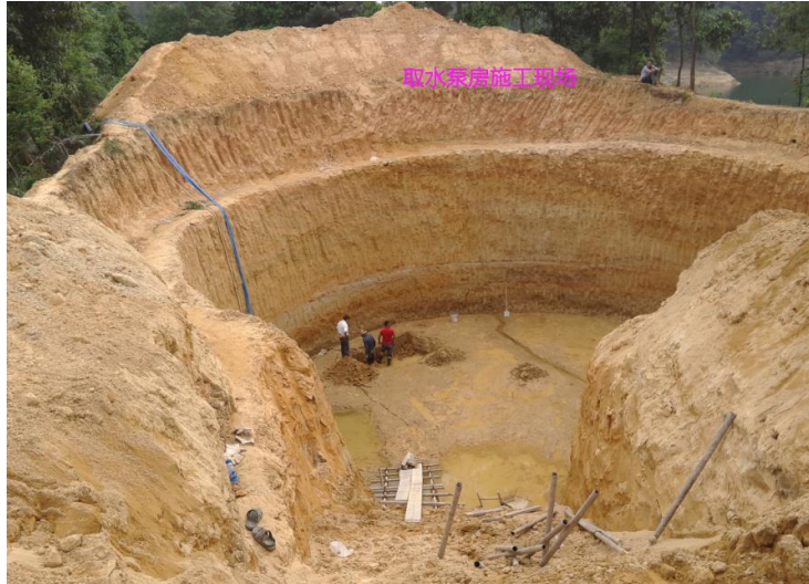
4、威远镇西水厂，设计规模 7000 \text{m}^3/\text{d} ，DN100-400 管道 15km。
